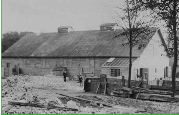
Noodkerk in Oisterwijk
